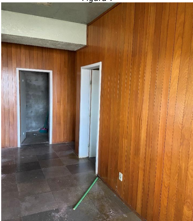
Vista Interna Acesso Lavanderia, Copa1 e Banheiros 1 e 2
