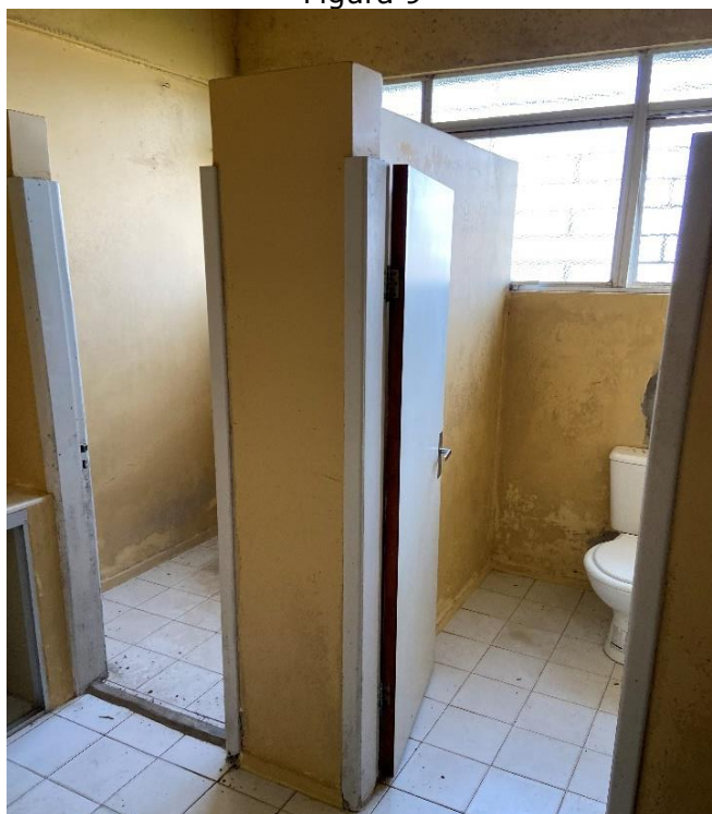
Vista Interna Banheiros 1 e 2 Existentes
