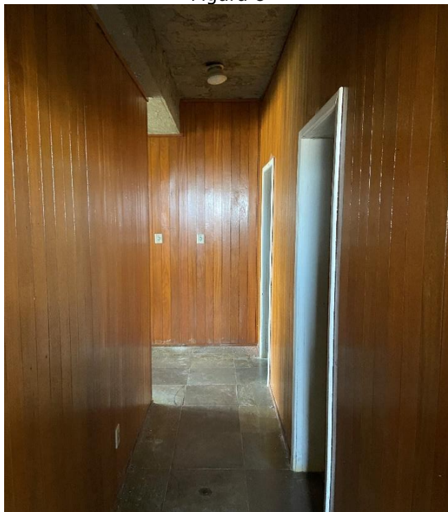
Vista Interna Saída Banheiros 1 e 3 Acesso Futuros Consultórios
