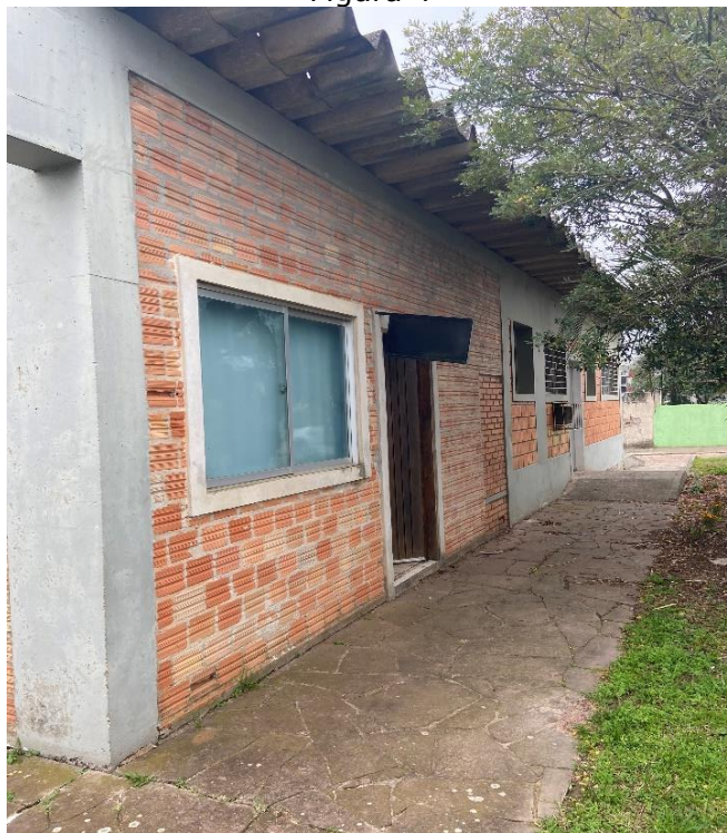
Vista Lateral Esquerda Sentido Fundos-Frente
