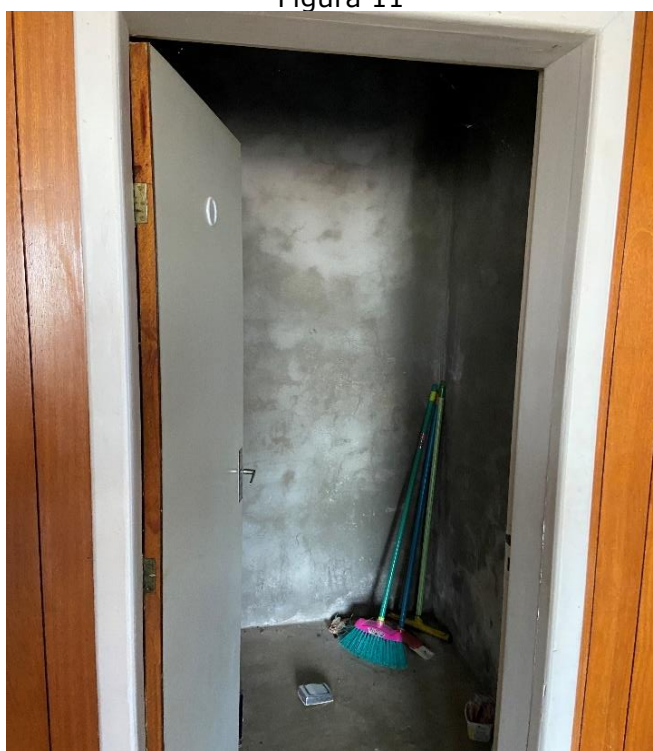
Vista Interna Lavanderia Existente
