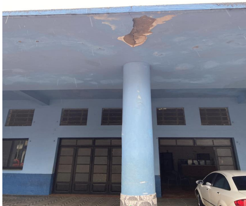
Vista Frontal Pilar/Marquise
