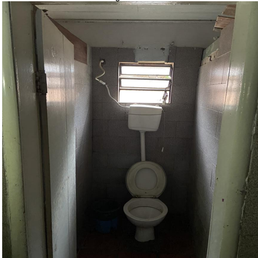
Vista Interna Banheiro Sanitário 2 Masculino
