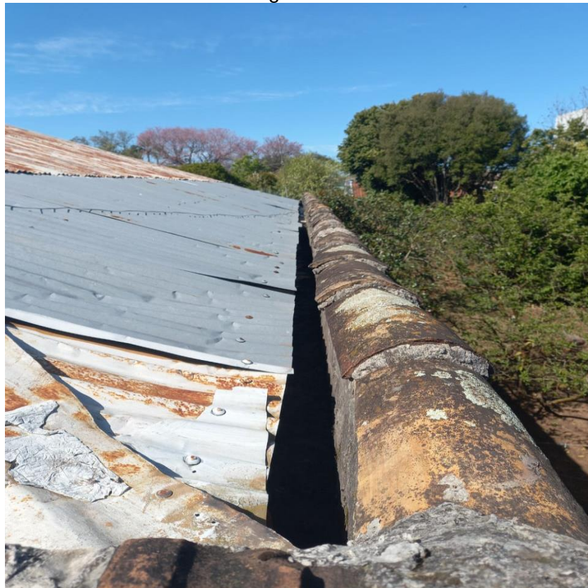
Vista Calha Lateral Direita Prédio
