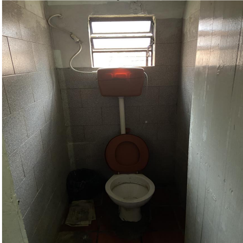
Vista Interna Banheiro Sanitário 1 Masculino
