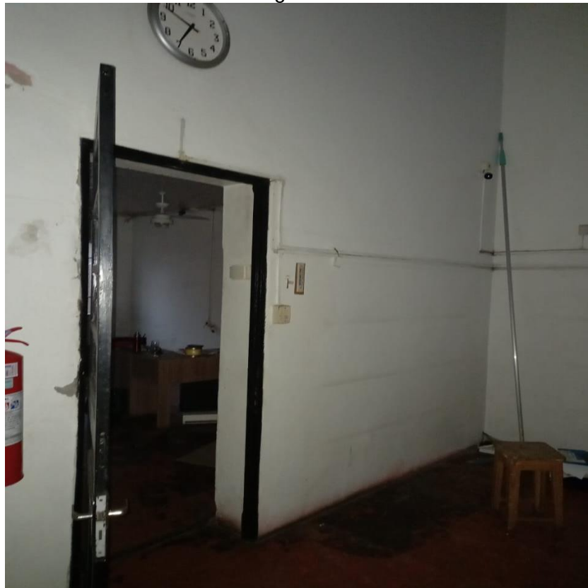
Vista Interna Prédio Salão Acesso Sala Escritório
