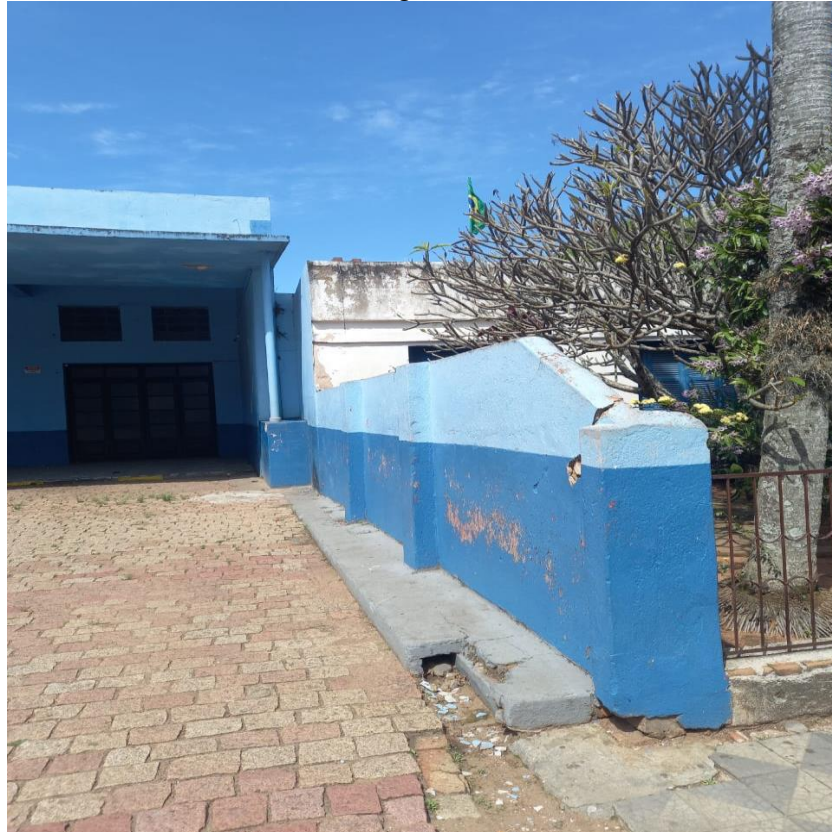
Vista Frontal Lateral Direita Muro
