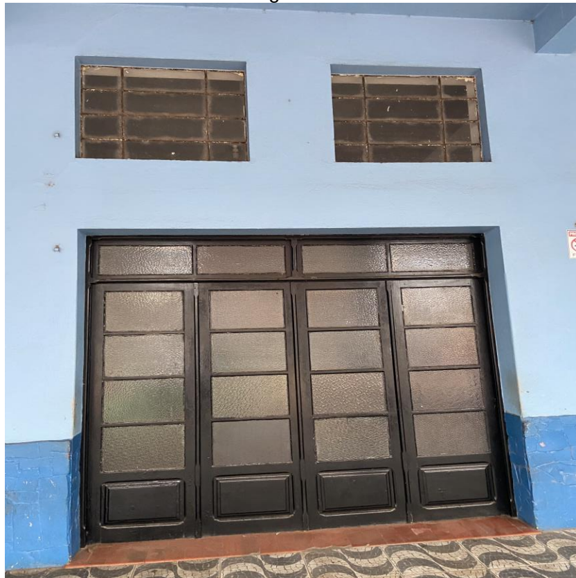
Vista Frontal Detalhe Porta Acesso Prédio
