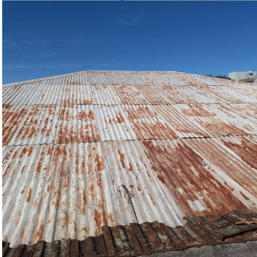
Vista Detalhe Telhado
