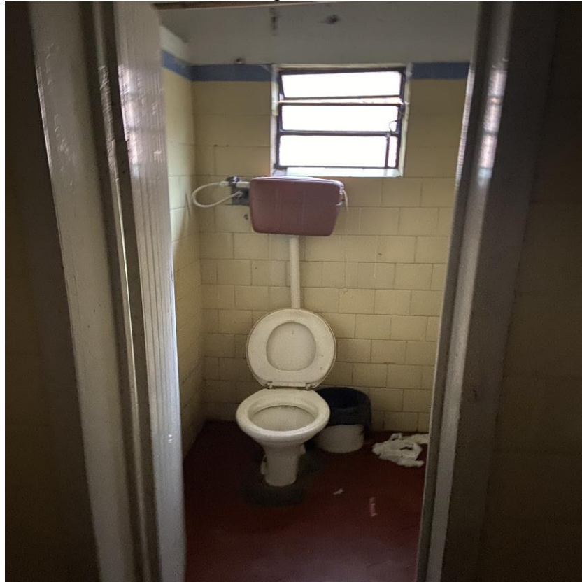
Vista Interna Banheiro Sanitário 2 Feminino
