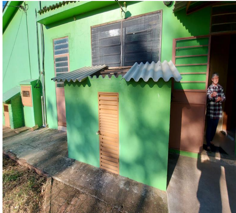
Vista Casa do Gás Existente
