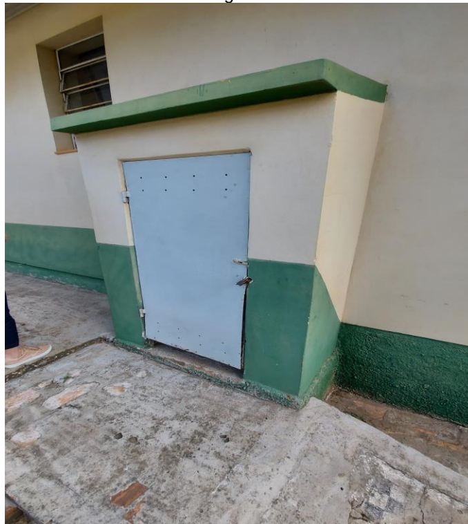
Vista Casa do Gás Existente
