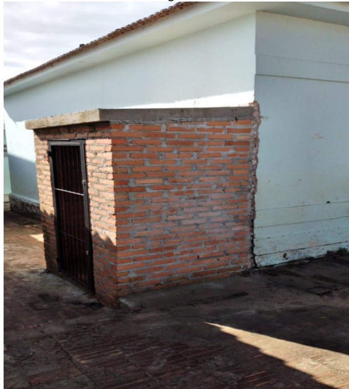
Vista Casa do Gás Existente
