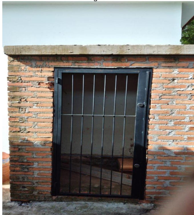
Vista Casa do Gás Existente
