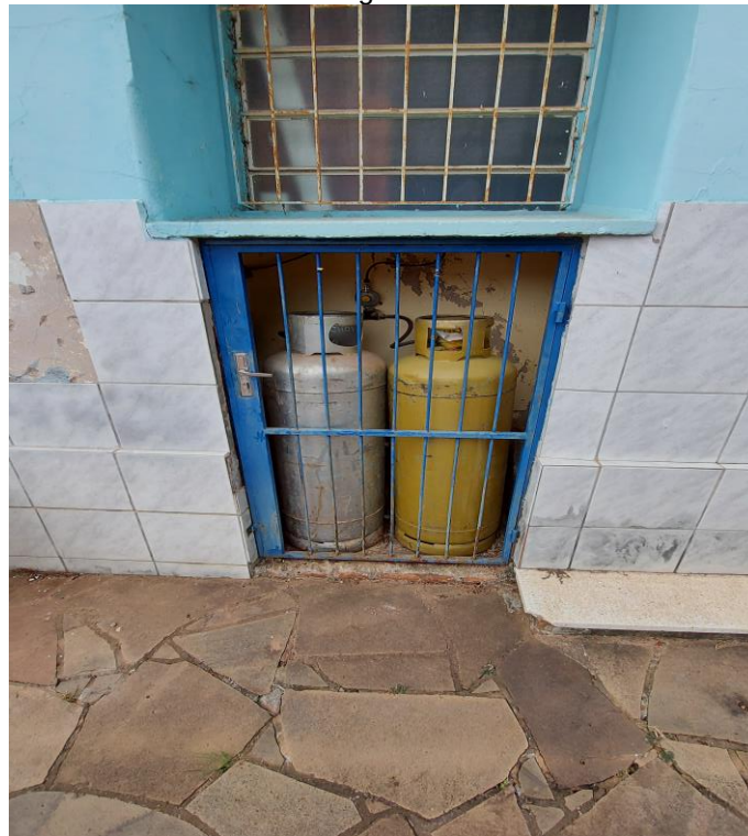
Vista Casa do Gás Existente
