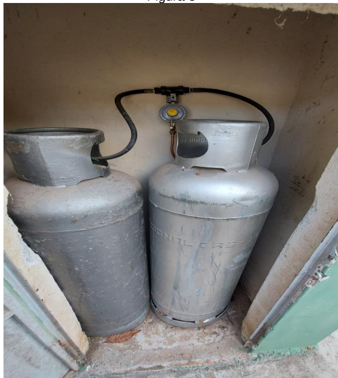
Vista Casa do Gás Existente
