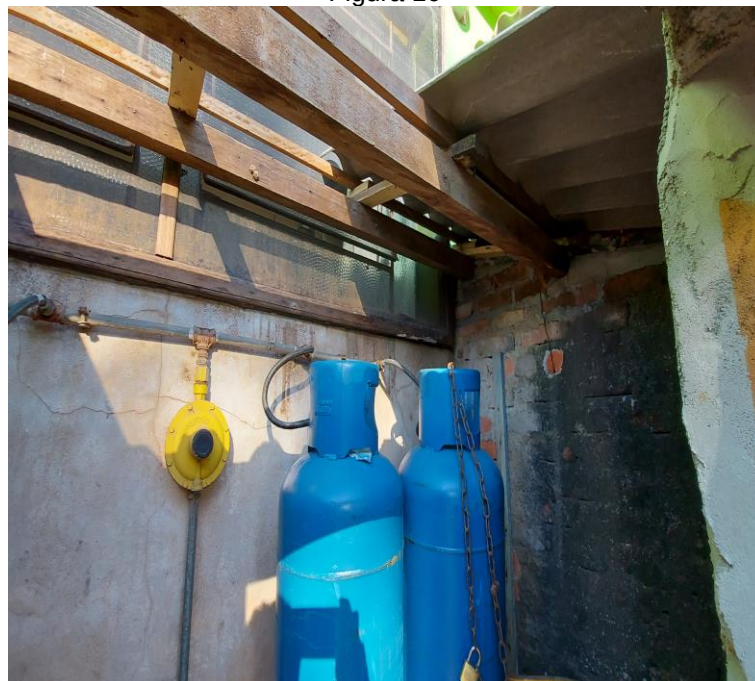
Vista Casa do Gás Existente
