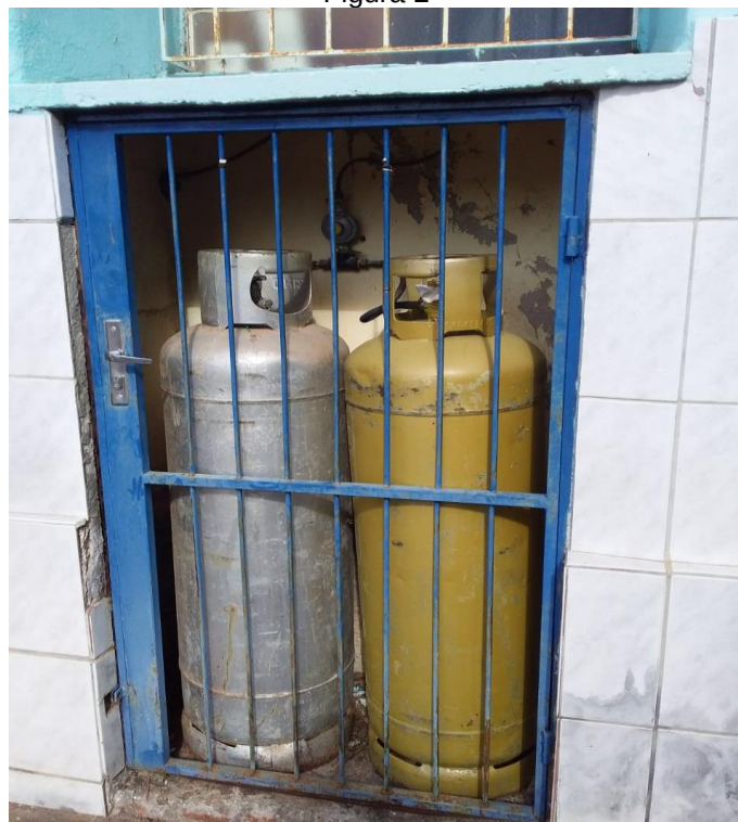
Vista Casa do Gás Existente
