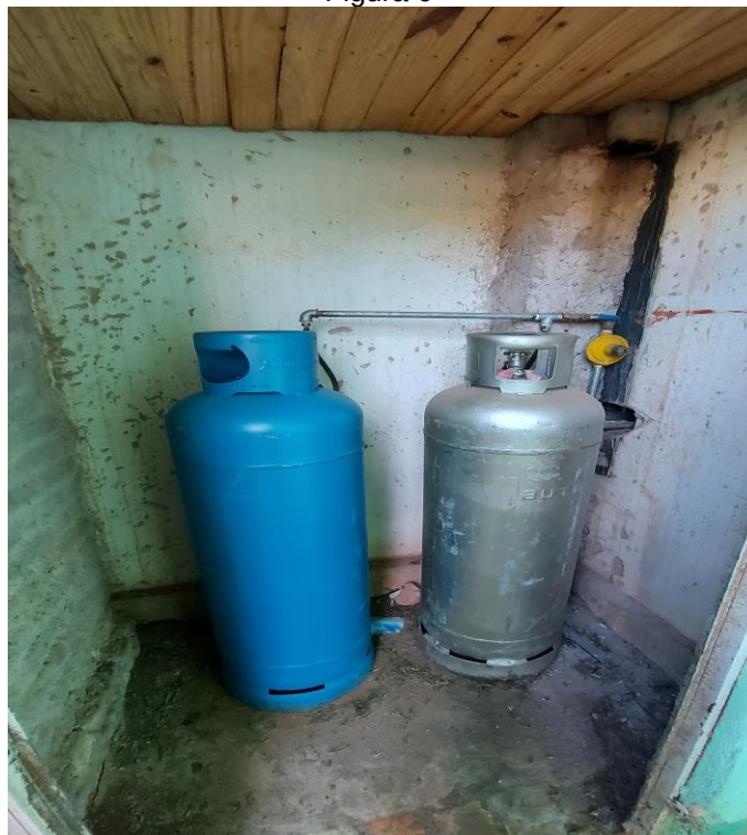
Vista Casa do Gás Existente
