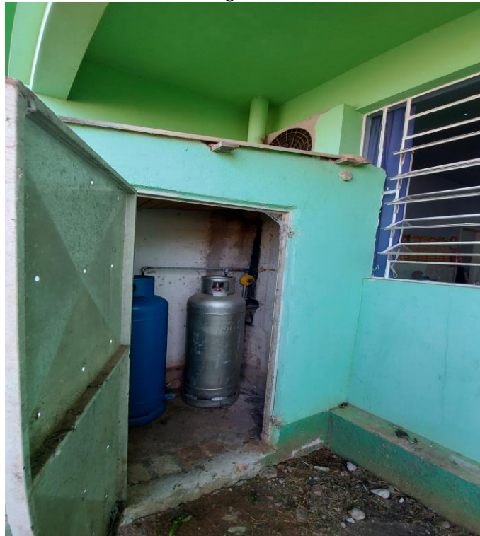
Vista Casa do Gás Existente
