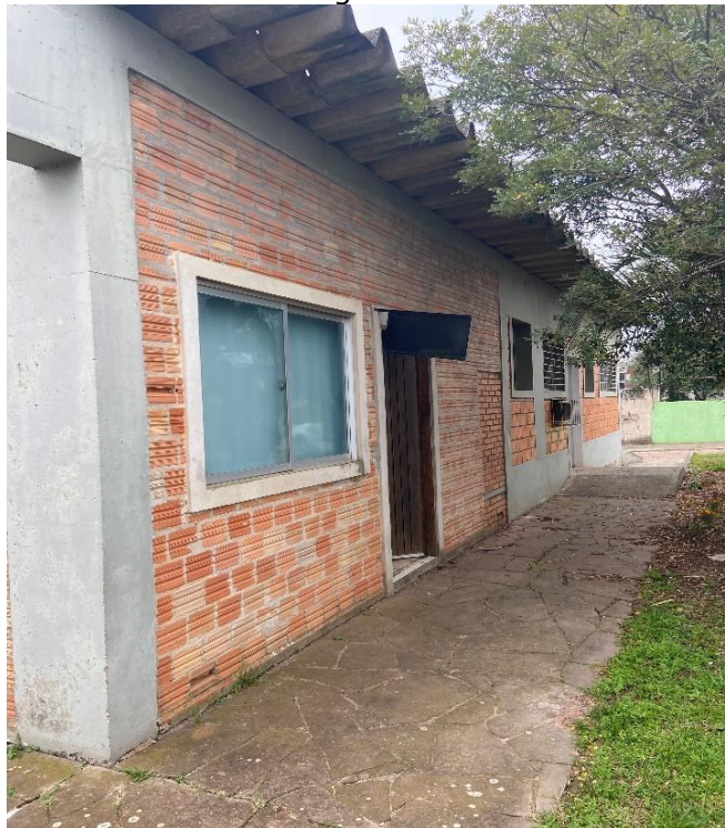
Vista Lateral Esquerda Sentido Fundos-Frente
