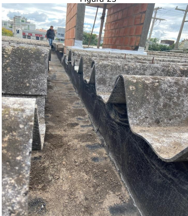
Vista Calha Existente a ser Reformada
