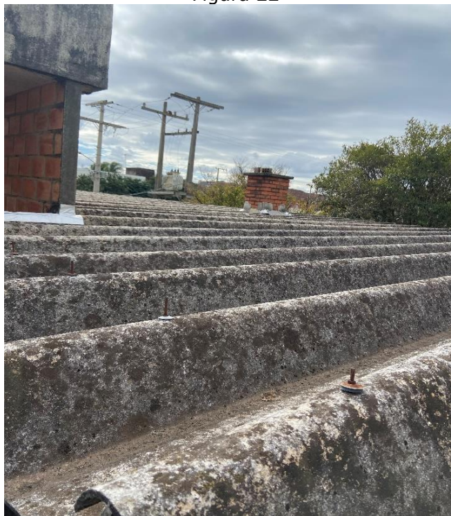
Vista Telhado Calhetão Existente
