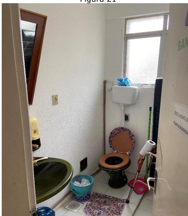
Vista Interna Banheiro Existente - Futuro Banheiro PNE
