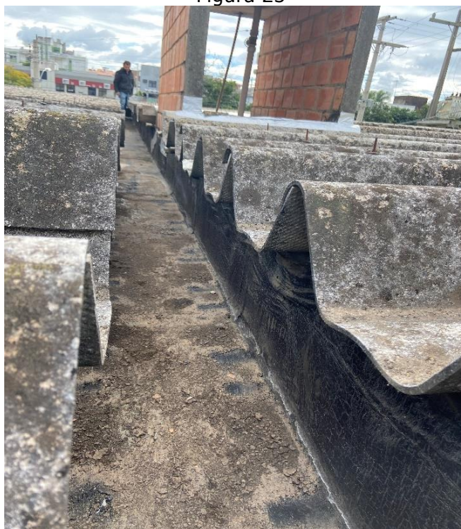
Vista Calha Existente a ser Reformada
