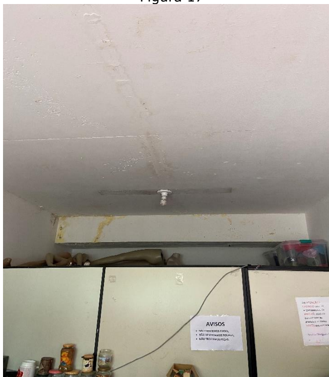
Vista Sala de Espera Existente
