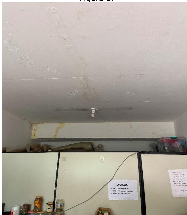
Vista Sala de Espera Existente
