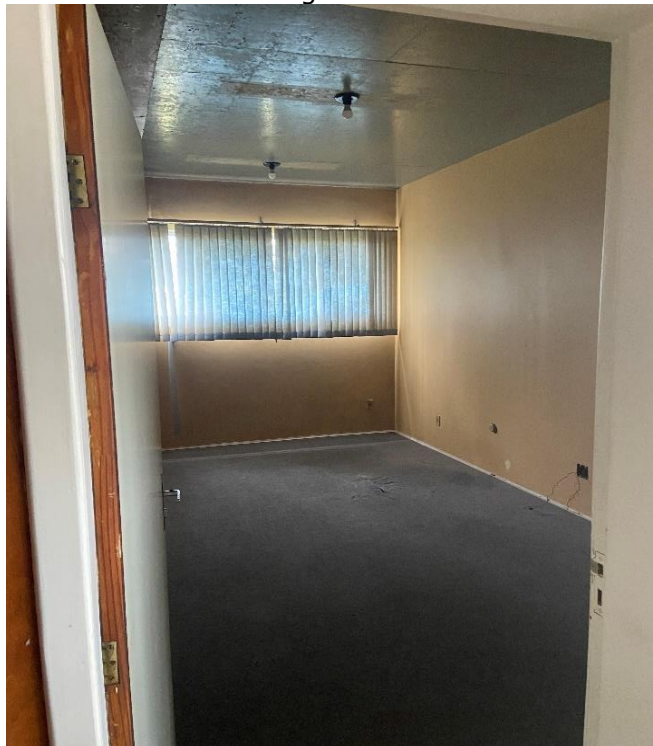
Vista Interna Futura Sala Ultrassonografia
