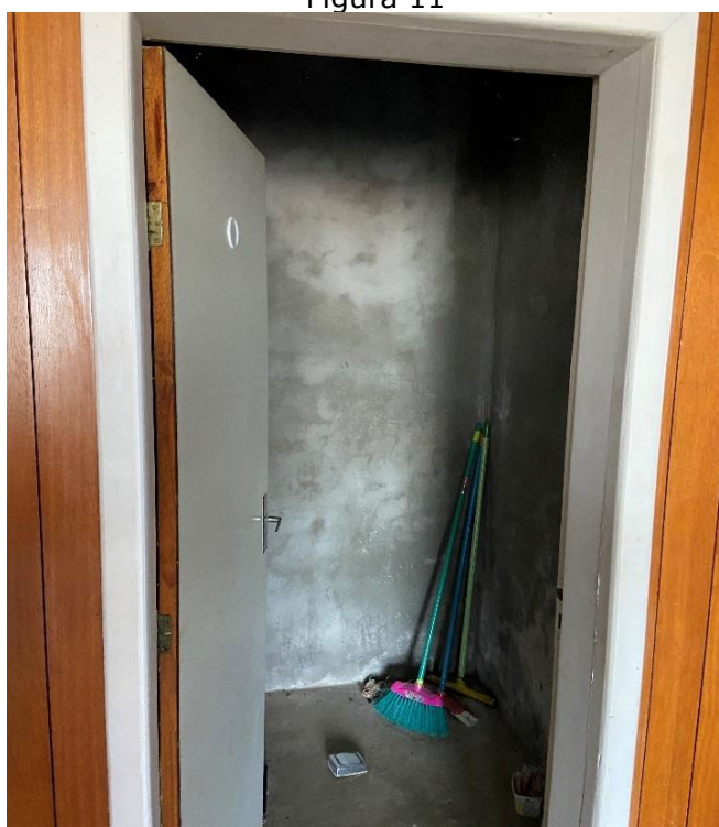
Vista Interna Lavanderia Existente
