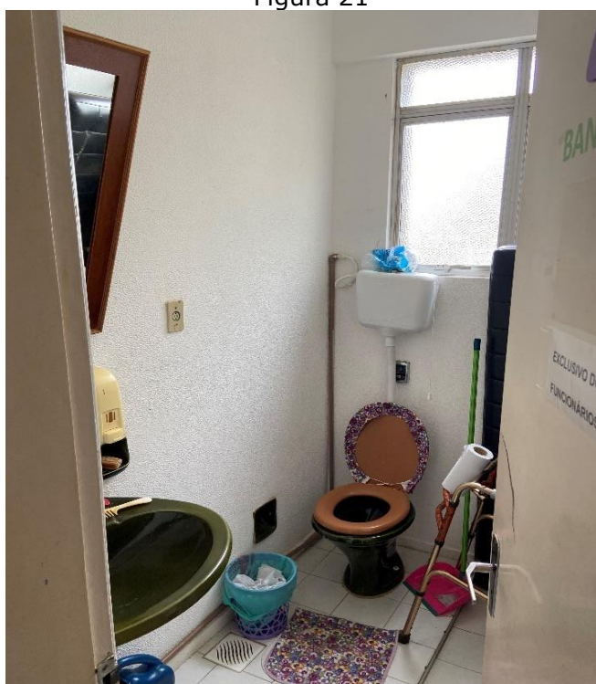
Vista Interna Banheiro Existente - Futuro Banheiro PNE
