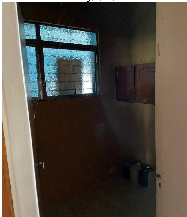
Vista Interna Copa 1 Existente
