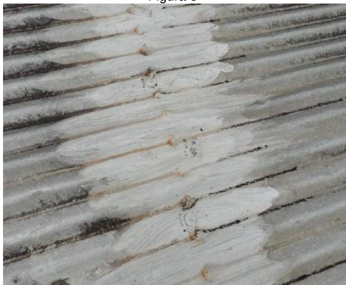
Vista Remendos Telhado Existente
