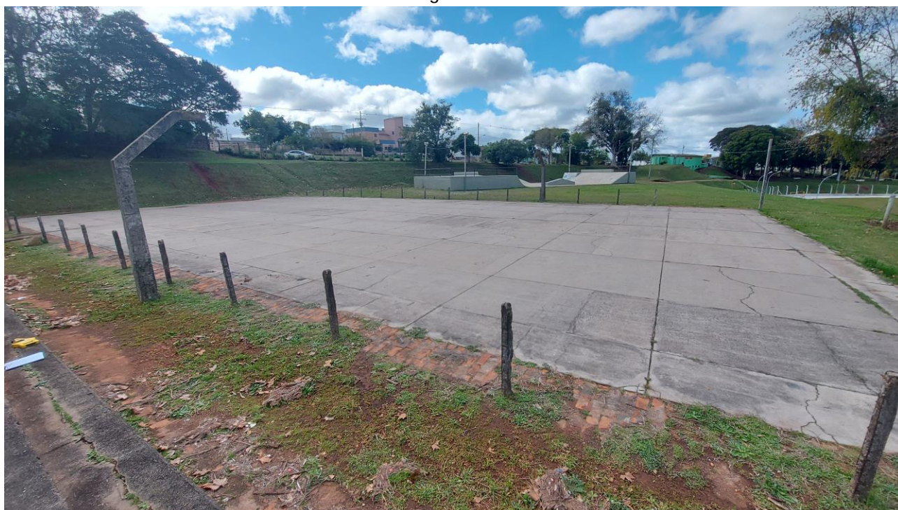
Vista Sentido Oeste - Leste
