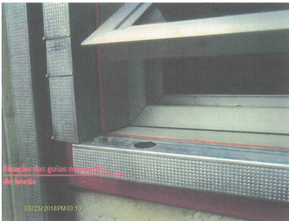
Ilustração 05 — Proposta de fixação dos montantes e guias
