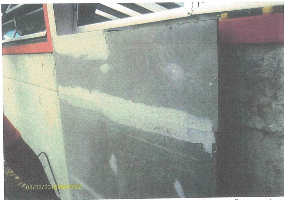
Figura 11 – Proposta de tratamento de juntas das placas cimentícias com fita trançada em PVC.
