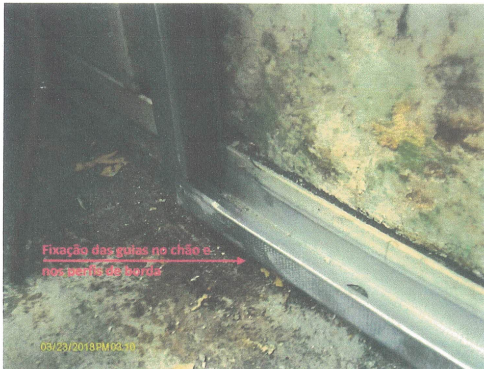
Ilustração 04 — Proposta de fixação dos montantes e guias
