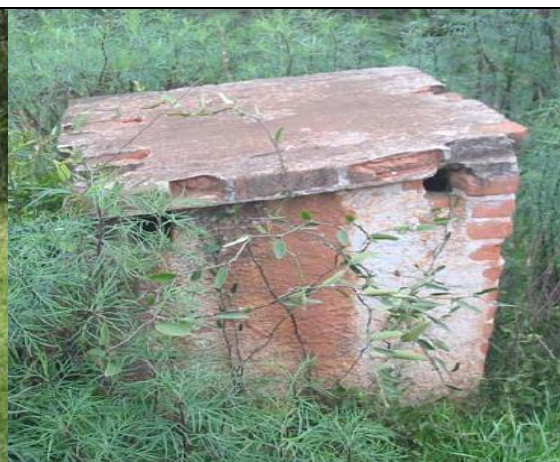
FOTO 02 – Sistema de Captação
