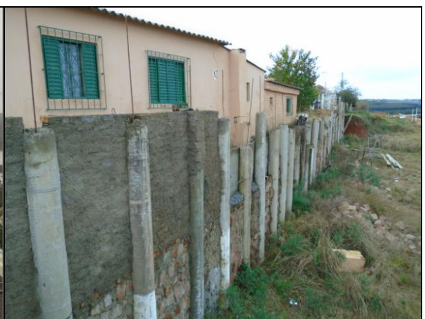
FOTO 06 – Muro de contenção
