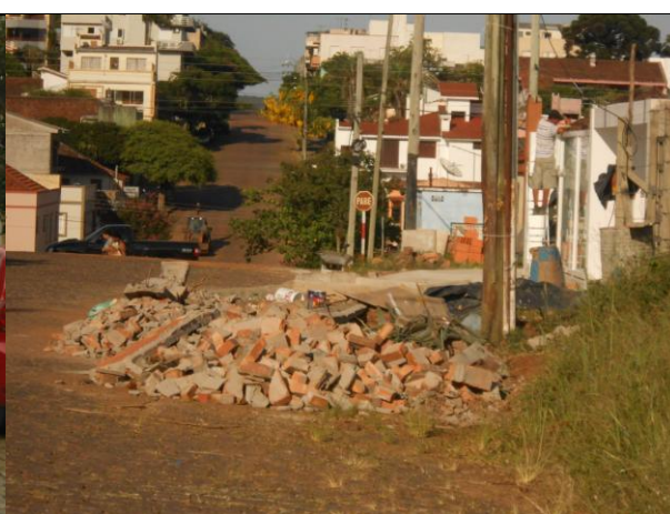
FOTO 06 – Disposição irregular de RCC
