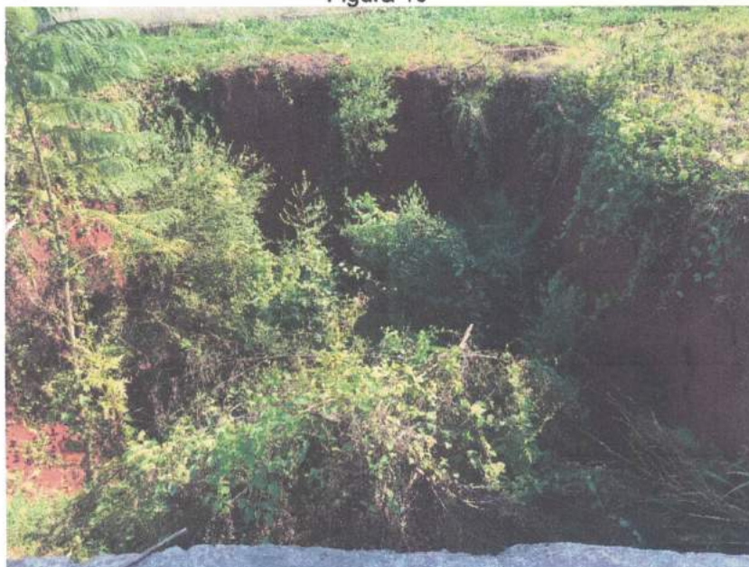
Vala de Erosão a ser Reaterrada Frente - bloco B1
