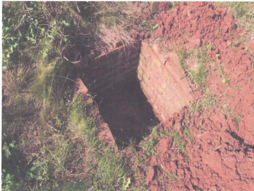
Caixa de Esgoto de Alvenaria
